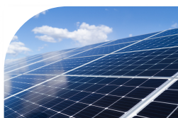
Sistema de energía solar
